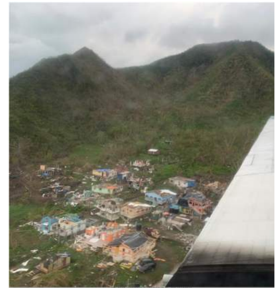
Viviendas sin cubierta y colapsadas 10/12/2020
