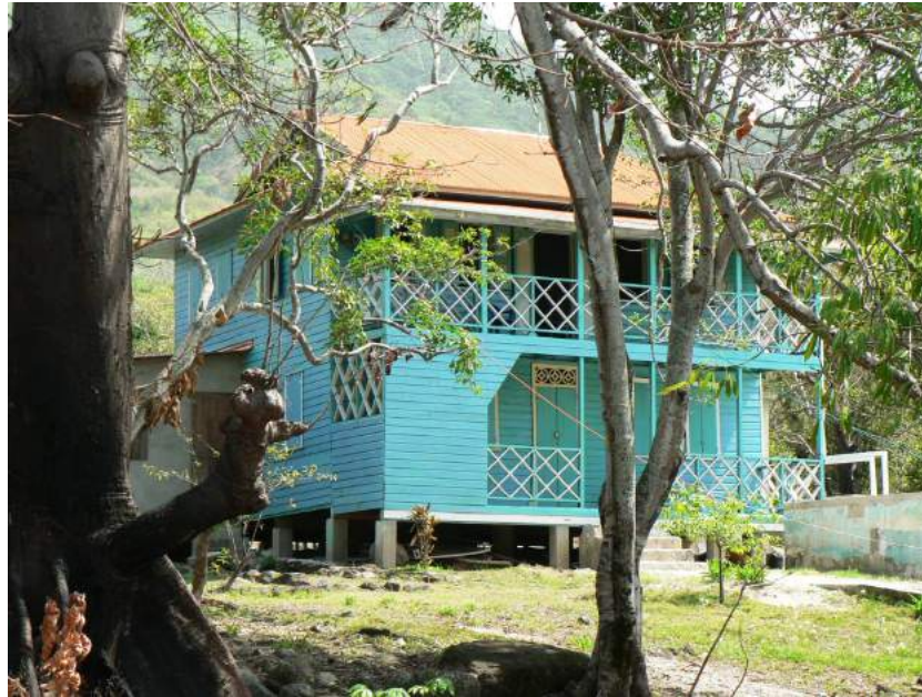
Fachada principal casa Cayetano Newball Smooth Water Bay Providencia Fotografía: Clara Eugenia Sánchez. 2006
